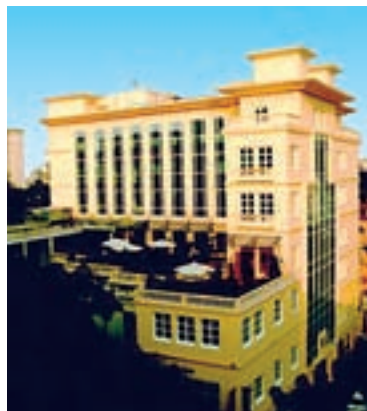
日系企業や外資系企業の進出が相次いでいるベトナムにおける物流事情を調査するため、本年9月、ハノイに駐在員事務所を開設いたしました。(写真は当社が入居しているオフィスビル)
