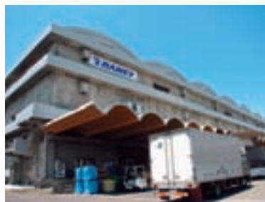
今般、東海団地倉庫株式会社の株式を追加取得し、本年3月末より同社が持分法適用会社となりました。これにより、名古屋支店港営業所西四区倉庫では、倉庫面積が増加しました。 (倉庫延床面積： 2,868坪 → 5,711坪)
